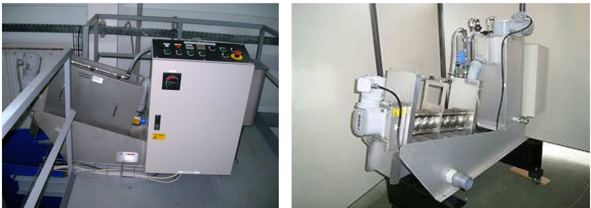
Рис. 2.84 Шнековый дегидратор (общий вид).
