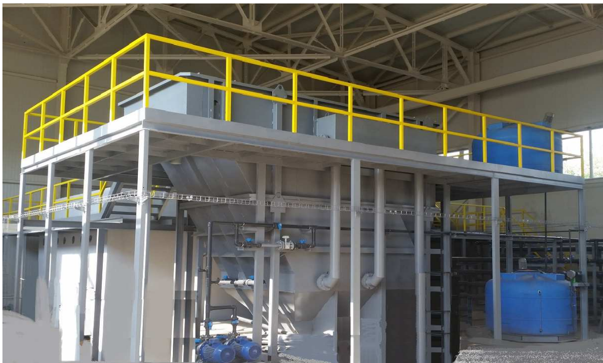
Рис. 2.78. Напорный реагентный флотатор.
